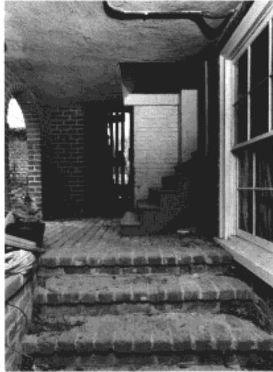
Basement passage beneath Room 106A
